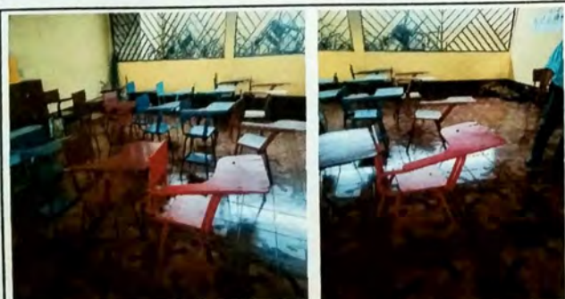
Foto 11: MODULO AULA se instalo piso ceramico sobre base de cemento liquido.
