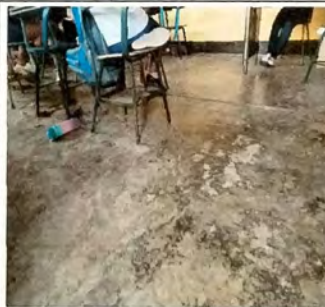
Foto 4: MODULO B Aula lateral derecha se instala piso ceramico sobre base de cemento liquido.
