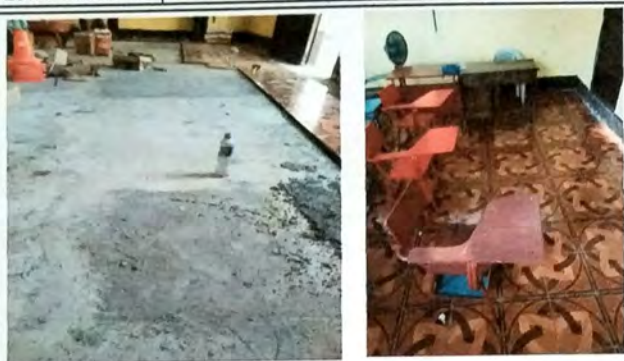
Foto7: MODULO Aula piso ceramico insalado sobre base de concreto.
