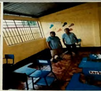
Foto 6: MODULO B aula lateral derecha, se instala piso ceramico sobre base de concreto.
