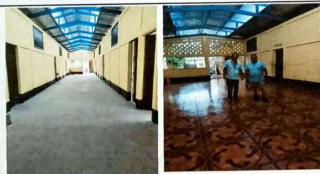
Foto 9: MODULO B corredor central, se instalo piso ceramico sobre base de concreto liso.
