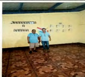
Foto 4: MODULO B Aula lateral derecha se instala piso ceramico sobre base de cemento liquido.
